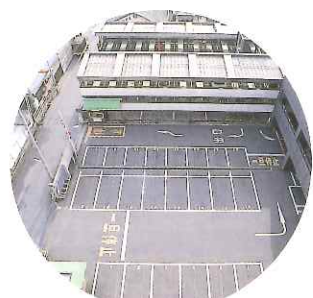
駐車場(100台収容)
